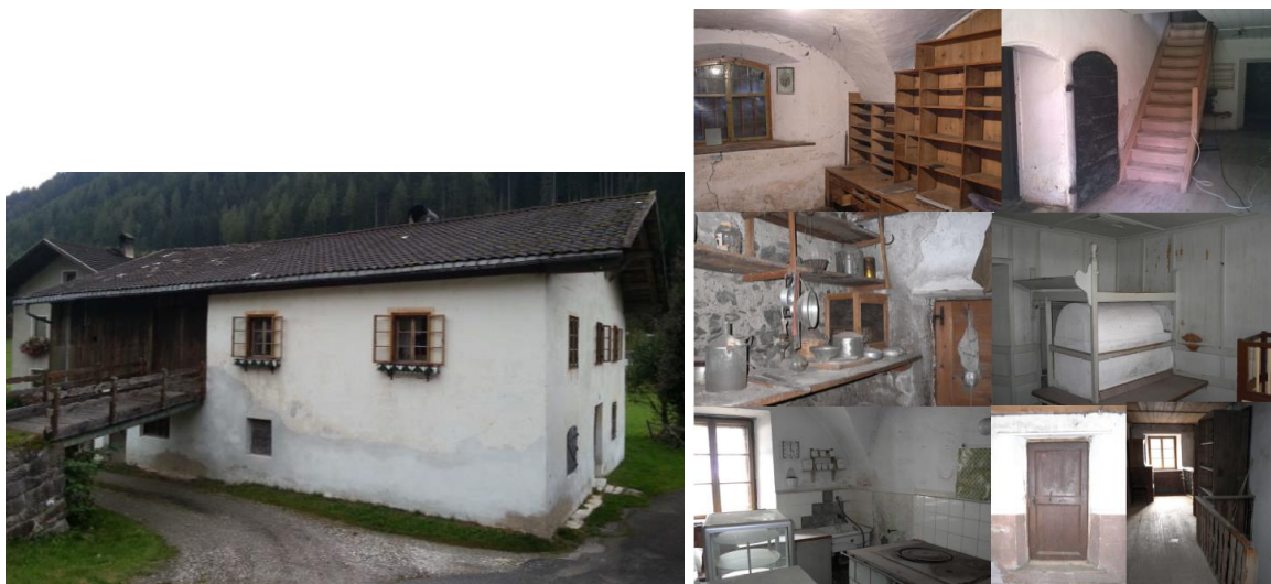
Abb. 3: Knablhof, vor Sanierung - Südtirol
