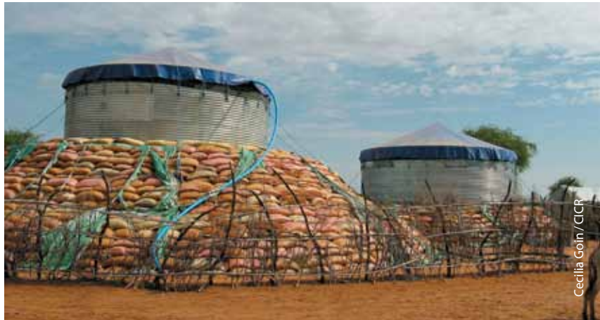
Figura 18 Instalaciones para el almacenamiento de reservas de agua de emergencia.
