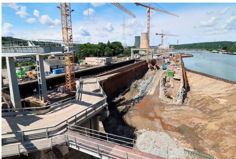
La nouvelle écluse a dû être construite sur une île entre le fleuve et une écluse maintenue en service. Cette spécificité a nécessité la construction d'un **pont provisoire** permettant l'accès à la zone de chantier.
