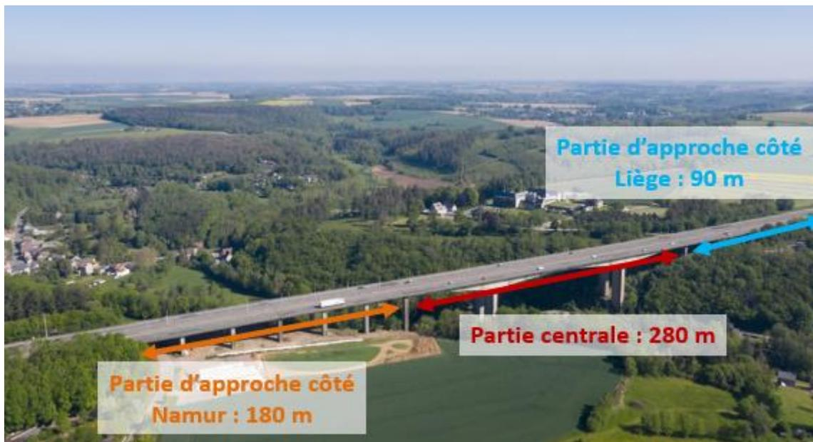
Le viaduc supporte un trafic journalier moyen d'environ 60.000 véhicules (2 sens cumulés), avec, aux heures les plus denses, 2.500 à 3.500 véhicules par heure (2 sens cumulés).
