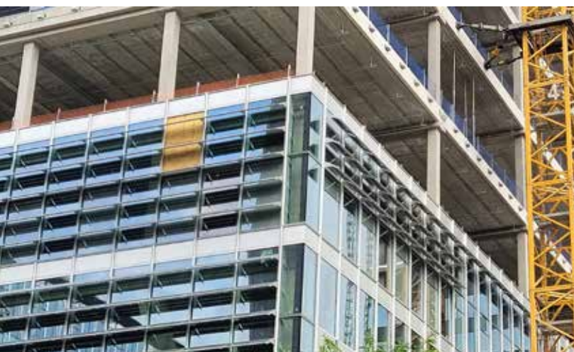
25 Vaste luifels bekleed met zonnecellen voor het Marie-Elisabeth Belpairegebouw te Brussel (ill. Facilitair Bedrijf)
