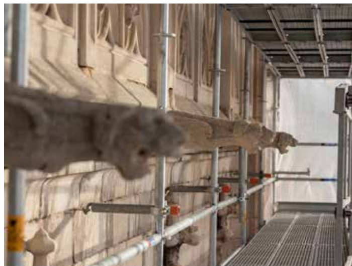
Gevelrestauratie van het Provinciaal Hof in Brugge (ill. Artes)
