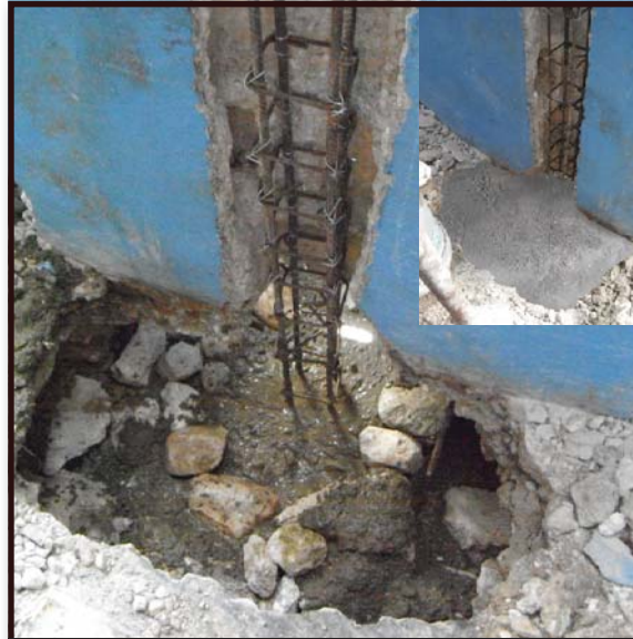
14. Nan fondasyon an, sevi ak gwo wòch epi vide beton pou ka plen twou a. Ant poto a ak wòch yo, kite yon distans 2.5 cm pou pi piti .
