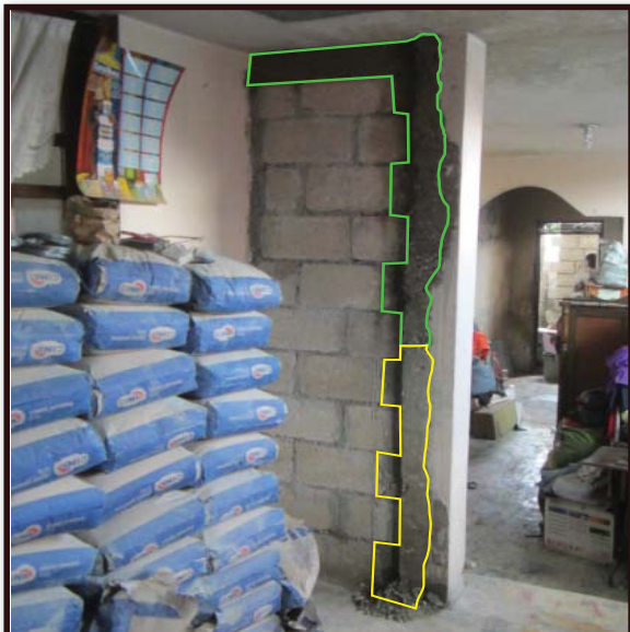
13. Retire kofraj la apre 48 èdtan, epi kontinye wouze beton an jan ou te kon n fe l la.
