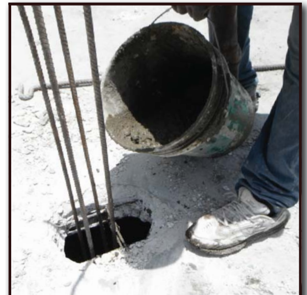
18. a Kanpe sou dal la epi koule beton an nan twou
