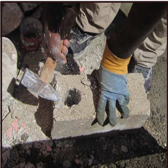
7. Sevi ak yon blòk ankè, kase pa anlè sou kote twou ki gen nan blòk la epi fè yon zorèy nan blòk la jan yo montre w li an.
