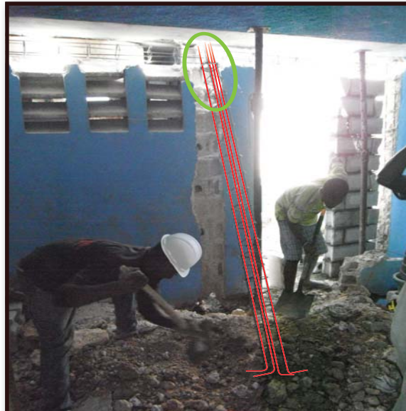
11. Mete kaj poto an plas . Sa ka mande pou nou kite kèk etriye ki nan tet poto a san mare .
