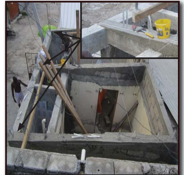
15. Tache yon fisel kom gid de fason pou 2 ba fè yo nan menm nivo ak rebò siperye ki sou deyo 4 ba fe yo, epi plen 2 ba fè yo.
