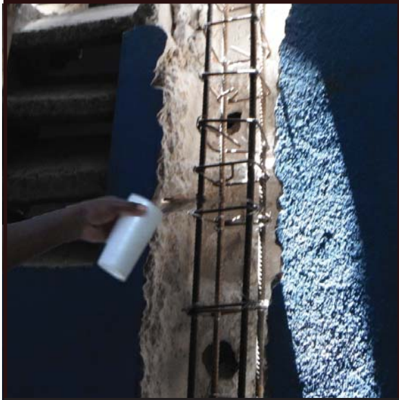
16. Mouye tout kote ki pral pran beton
