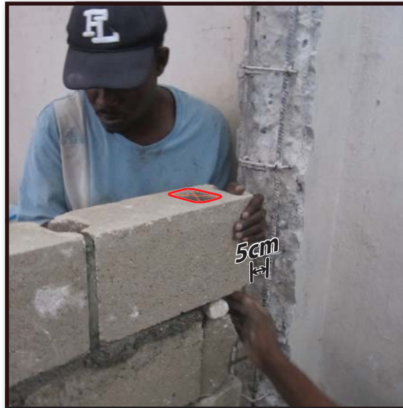
5. Konstwi mi an. Kite 5cm ant mi an ak amati a. Pèse yon twou nan dènye selil blòk la pou pèmèt beton an byen kole nan mi an.
