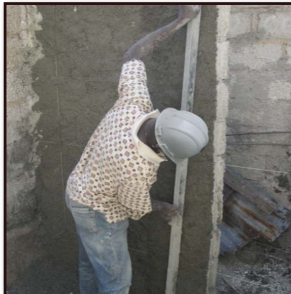
5. Itilize yon fisèl tankou gid, sèvi ak yon règ dwat pou rasire nou ke kouch randuisaj la swa, nan epesè yo mande a.
