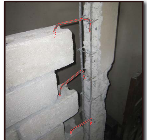
6. Sou chak de(2) ranje blòk, mete yon bout fè ki gen fòm U pou konekte mi an ak poto a. Fè sa sipoze konekte ak etriye ki nan poto a nan yon pwent epi lòt pwent lan antre nan twou blòk la.
