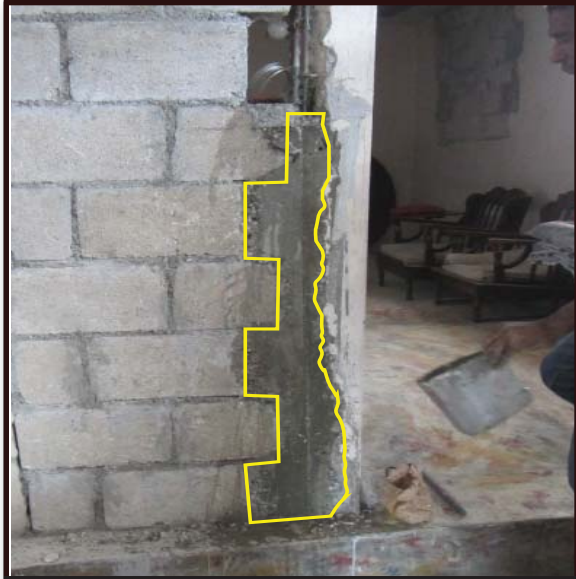
10. Apre 48 èdtan, retire kofraj la nan pati ki te koule anvan an epi kontinye wouze li .
