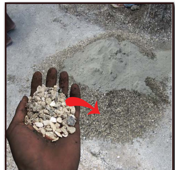
13. Koumanse pare beton an. Melanj nou dwe itilize a se :1 bokit siman , 2 bokit sab ak 3 bokit gravye(6cm-12 cm). Li nesese pou mete gravye a paske l'ap bay beton an plis rezistans.
