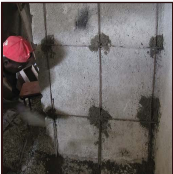
14. Kòmanse mete beton an nan twou nou te fè nan mi an nan etap 10 la.
