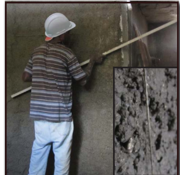
16. Kouch apre kouch, aplike beton an jiskaske w rive nan fisèl l an.
