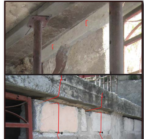
3. Kofre yon bò nan pati ki gen vid la. Pou sekize 2x4 la, sevi ak klou beton epi fil alegati.
