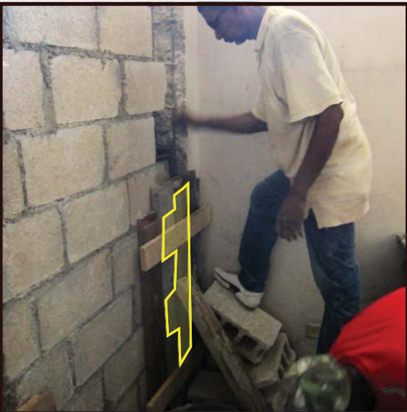
7. Koule beton sou yon bò ou sou lòt la pou rive nan mwatye mi an. Frappe kofraj la ak yon mato pou vibre beton an epi sevi ak yon bout fè pou konsolide li .( beton an)
