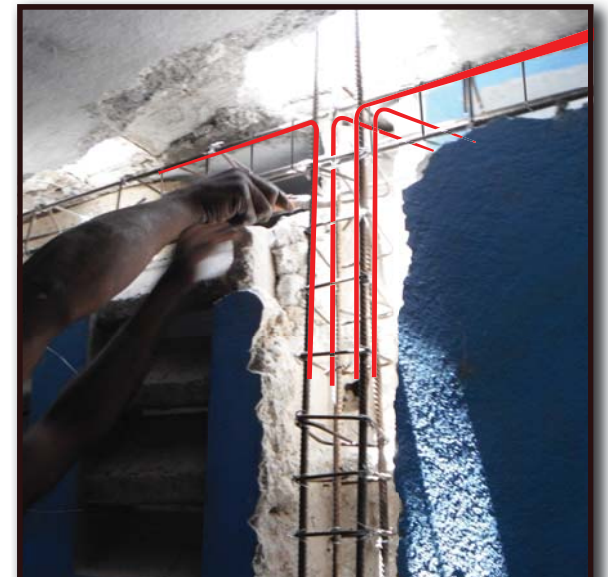
12. Le nou mete poto an plas, mare denye etriye yo, rasire nou ke yo konekte ak chennay siperyè a jan règ yo mande ! I an. Sa vle di nou sipoze itilize 4 L kap la pou konekte poto a ak chennay siperyè a.
