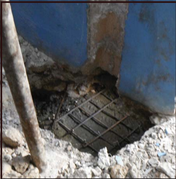
10. Depoze semèl la sou beton an .
