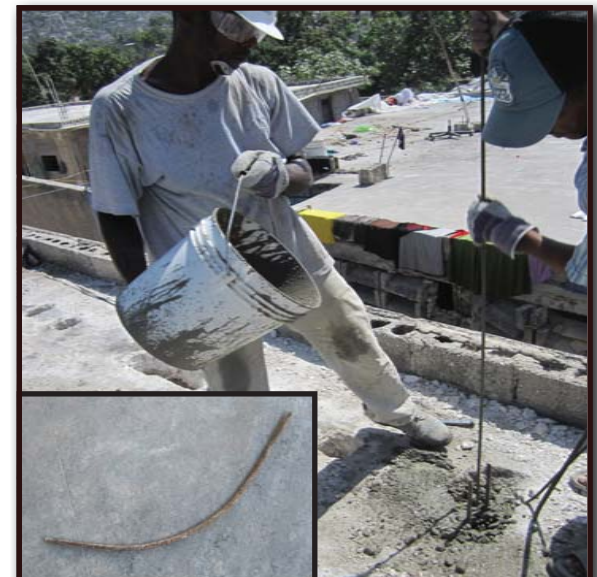
12. Vide beton an apati twou ki nan dal la .Vibre epi konpakte ak yon tij fè ak yon mato. Sevi ak yon fè ki gen yon koub ladan pou nou rive jwen tout kote ki difisil pou jwenn.
