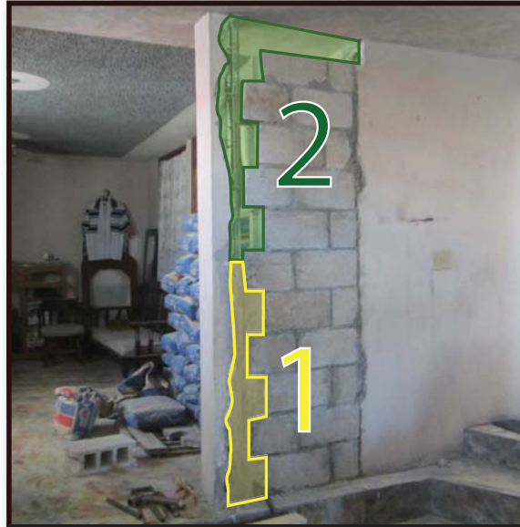
8. Koule beton an de(2) fwa. Sa ap pèmèt beton an pi byen antre nan tout longè kote ki kwense yo. Metòd sa ap anpeche nou koupe bwa kofraj egzakteman nan wotè plafon an.
